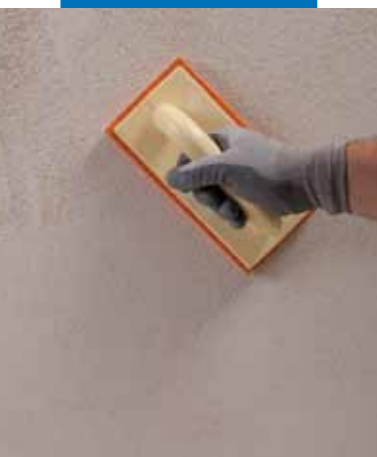
Konečná úprava povrchu Mape-Antique FC Grosso houbovým hladítkem
