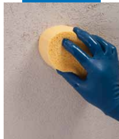
Konečná úprava povrchu Mape-Antique FC Grosso houbou
